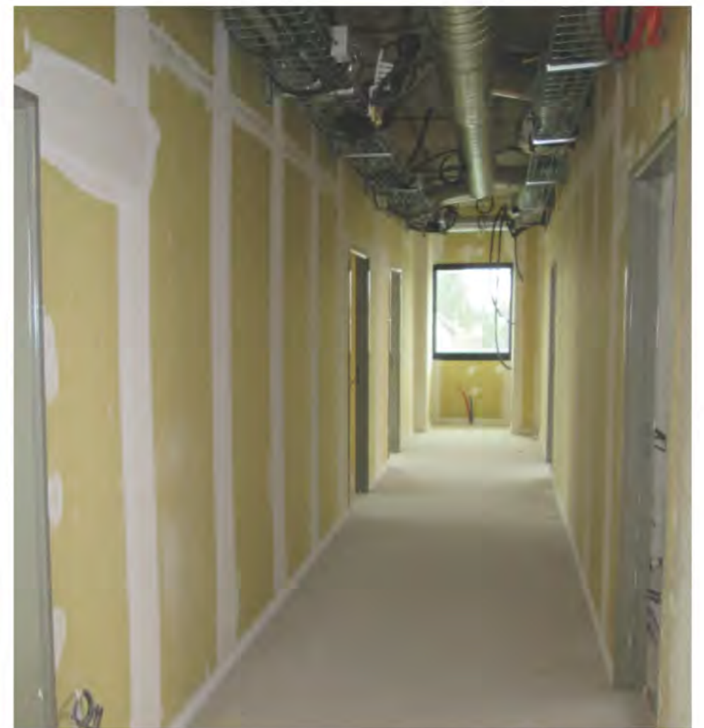
> Couloir 2 ème étage
