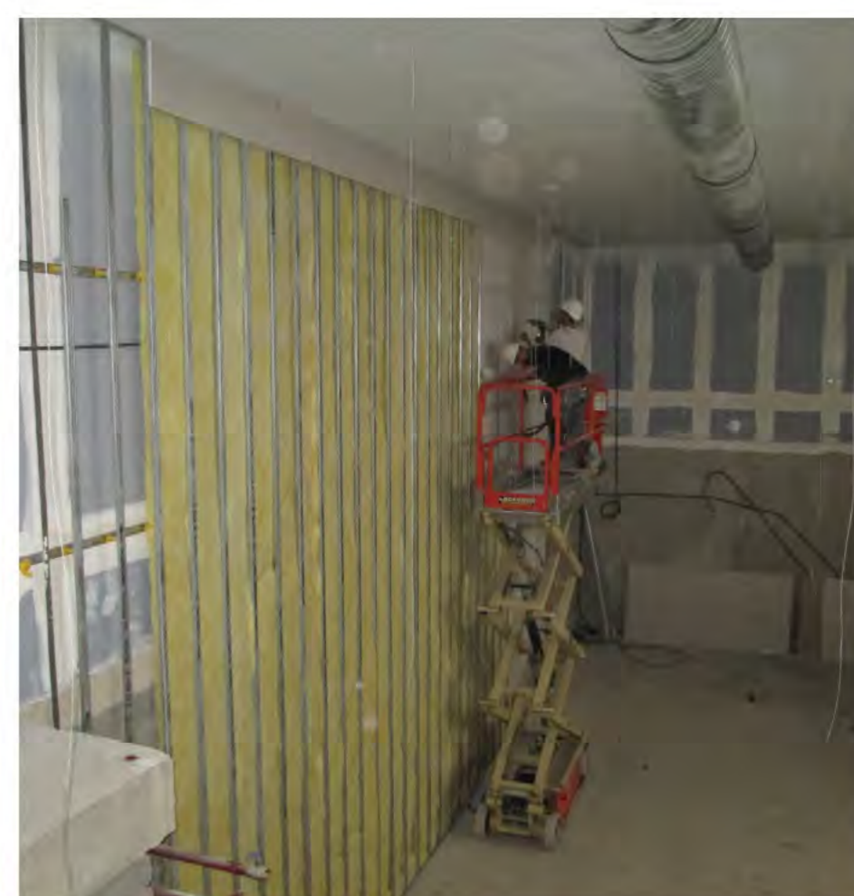
> Cloisons en cours de pose
